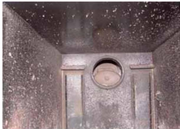
Vergaserkammer nach einigen Tagen Heizbetrieb. Die Teerbildung ist völlig normal.
