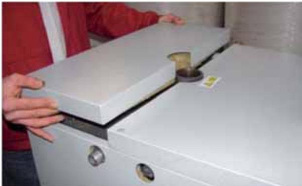
Abnehmen der Wärmetauscherverkleidung (werkzeuglos)
