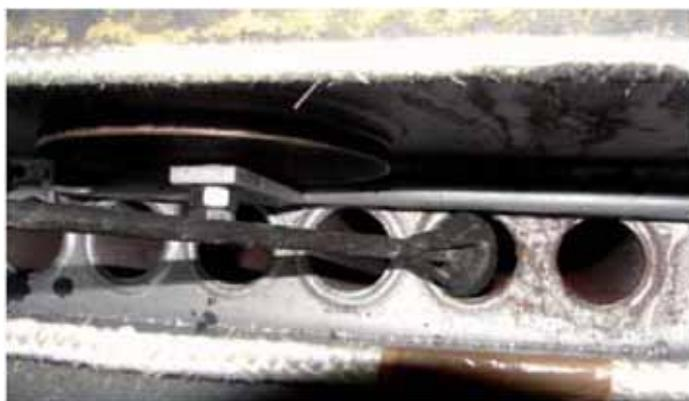
Reinigen Sie den Wärmetauscher mit dem Rundschraper
