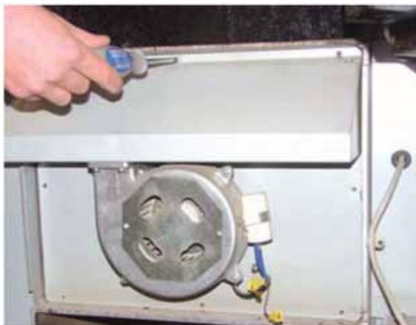
Schrauben des Ventilatorbleches lösen und das Blech samt Ventilator abnehmen. Bei der Wiedermontage darauf achten, dass die Dichtung sauber anliegt.
