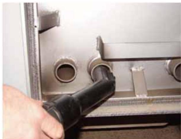
Die Primär- und Sekundärluftkanäle mit dem Staubsauger reinigen.
