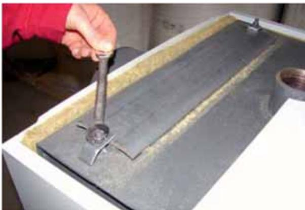
Lösen der Wärmetauscherabdeckung (13-er Gabelschlüssel)
