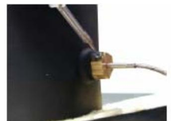
Abgasfühler mit einem sauberen Tuch reinigen, Abgasfühler einschieben und mit Fixierschraube handfest fixieren;
