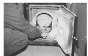
Hebel der Reinigungseinrichtung mehrmals wöchentlich betätigen (je 5-10 mal auf und ab);
